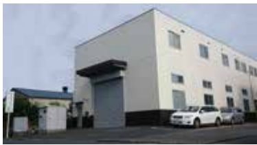
駅反対側からの外観
